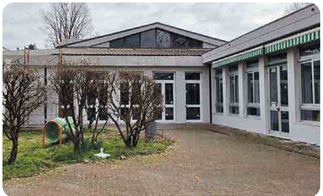
Immagine dopo i lavori
