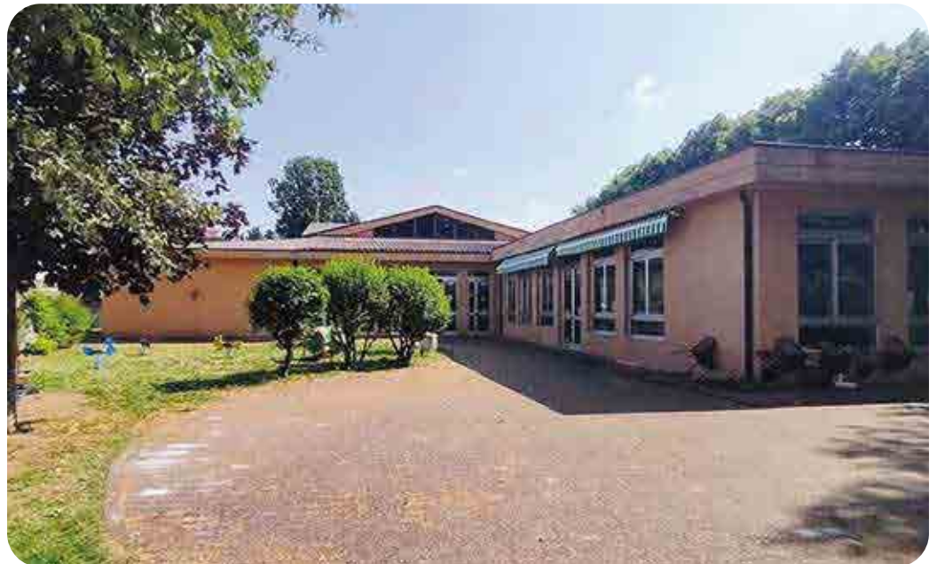
Immagine prima dei lavori
